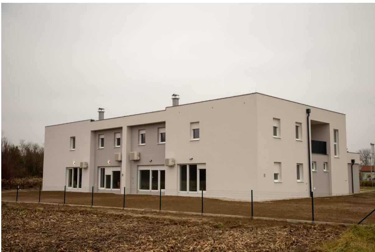
Slika 10. Završene 2 obiteljske kuće na lokaciji „Cvjetna“
