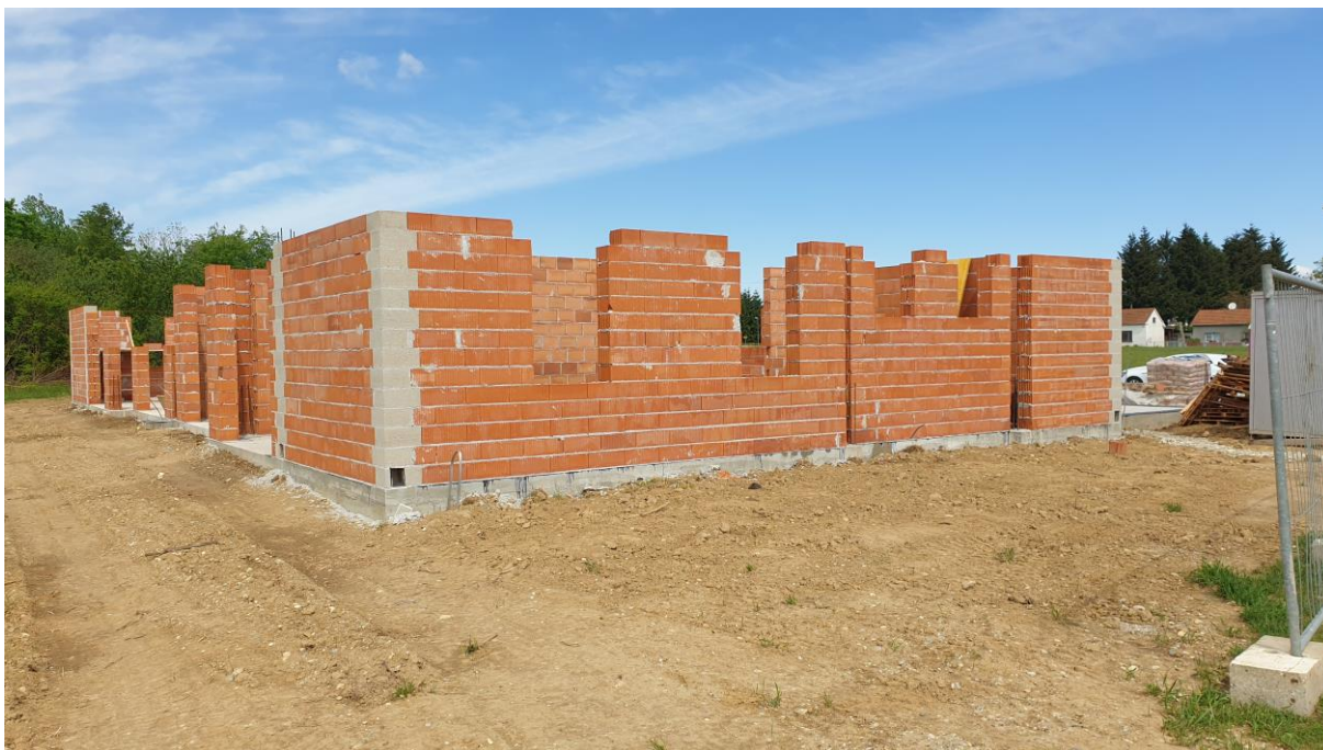
Slika 9. Izgradnja 2 obiteljske kuće na lokaciji „Cvjetna“
