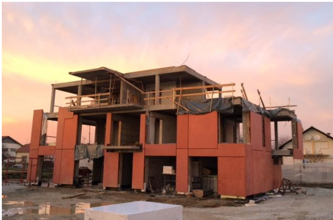
Slika 8. Završena PRVA ECO-SANDWICH kuća
