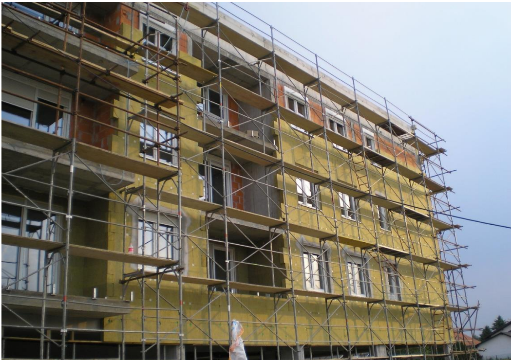
Slika 2. Izgradnja P31- obloga od mineralne vune
