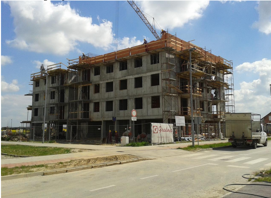
Slika 5. P29 u izgradnji
